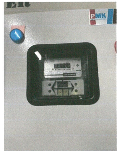
รูปภาพที่ 2.41 มิเตอร์ระบบบำบัดน้ำเสีย
